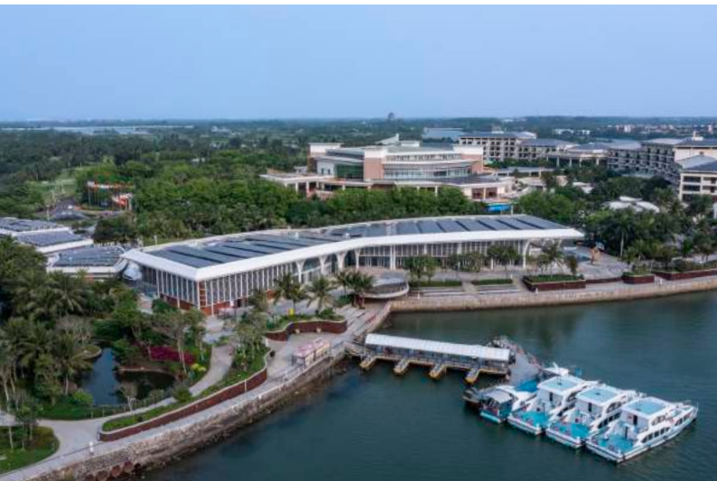
▼ 新闻中心码头 俯瞰
