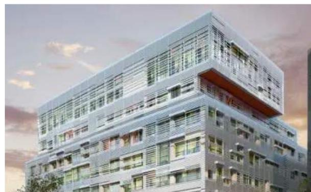
建筑外表皮骨架与大尺度开窗的设计增加了遮阳效果，有利于节能。
